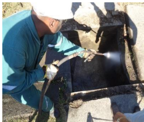
Limpeza de sistema hidrossanitário
