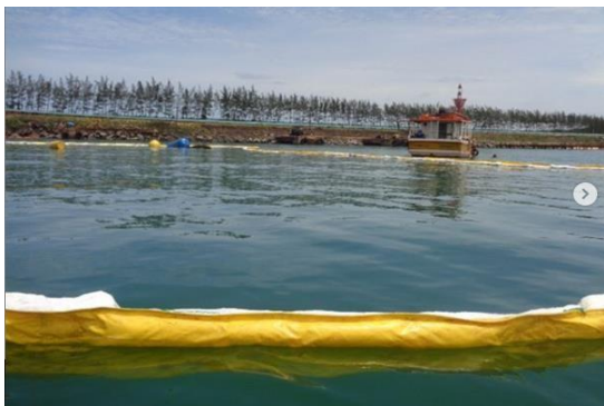
Cerco preventivo e materiais para combate a vazamento de hidrocarbonetos em ambientes marinhos.
