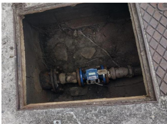
Posição do hidrômetro da CESAN
