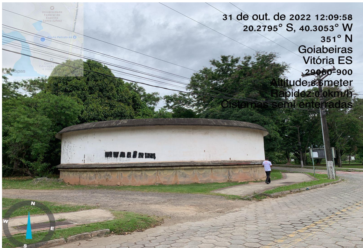
Imagem do Reservatório Semi-enterrado 02
