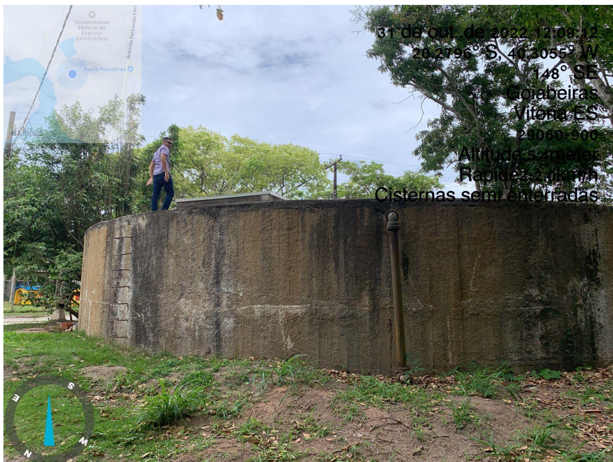
Imagem do Reservatório Semi-enterrado 01
