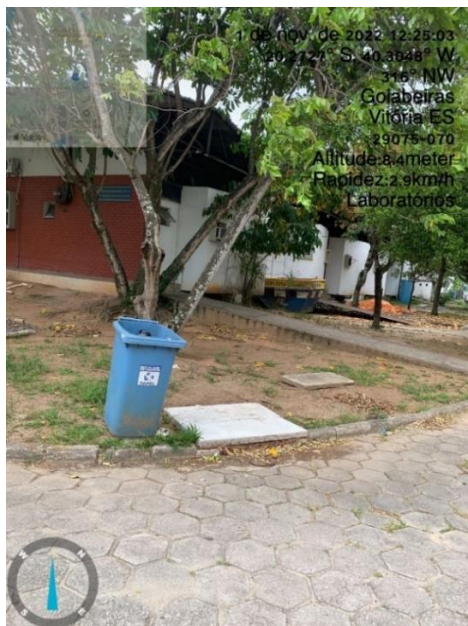
Figura 04 – Boca de Lobo Simples Existente.
