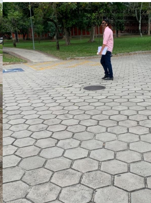
Figura 03 – Poço de Visita Existente.
