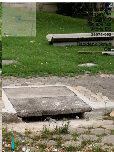
Figura 05 – Boca de Lobo Dupla Existente.
