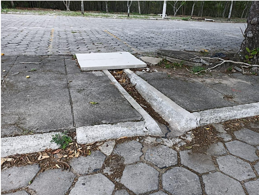
Figura 06 – Boca de Lobo Dupla Existente com calhas abertas.
