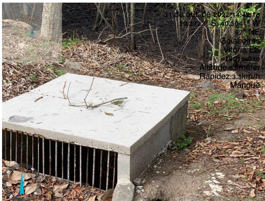
Figura 10 – Boca de Lobo com Desagué Natural.
