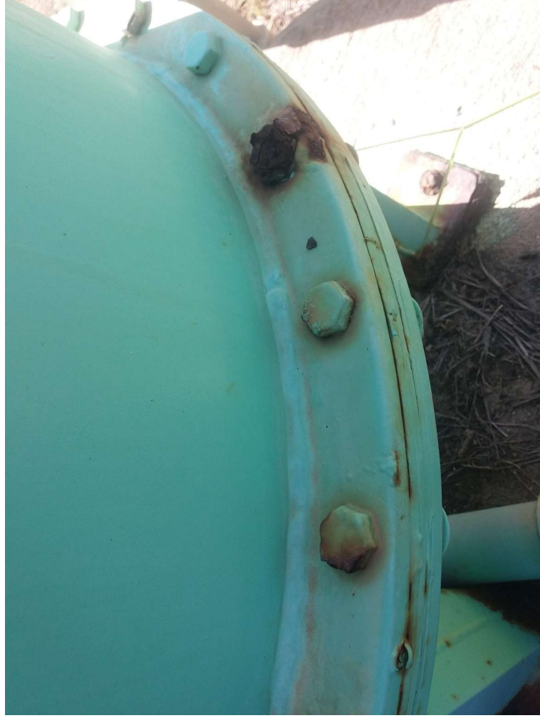
Foto 04: Tratamento contra corrosão
