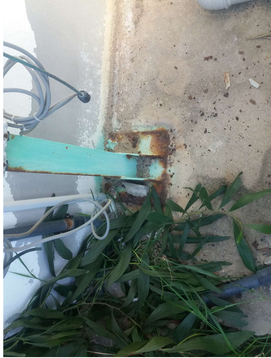
Foto 05: Tratamento contra corrosão
