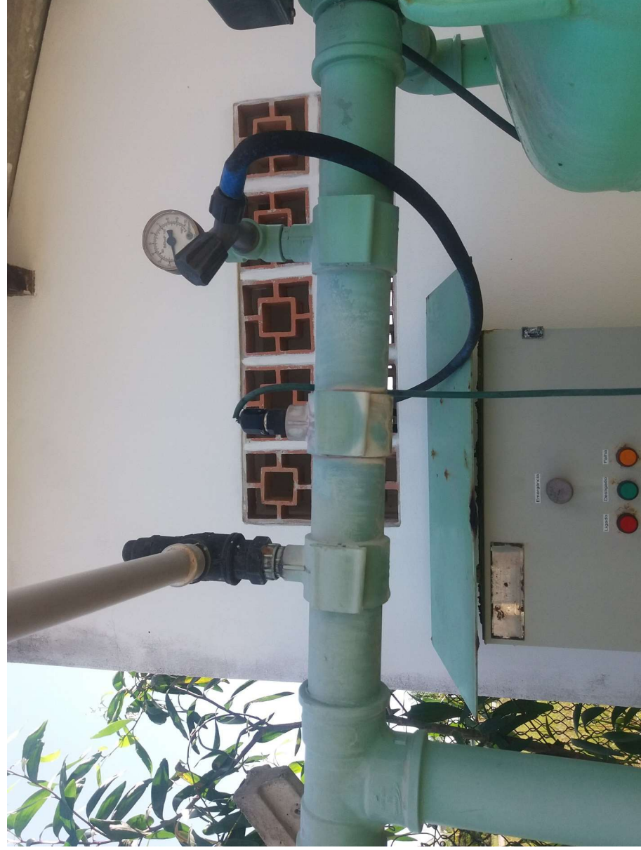
Foto 07: Substituição das mangueiras
