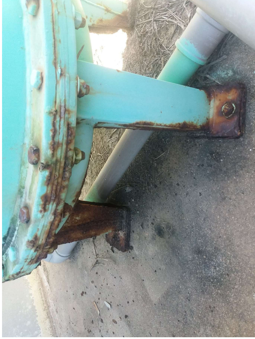
Foto 03: Tratamento contra corrosão
