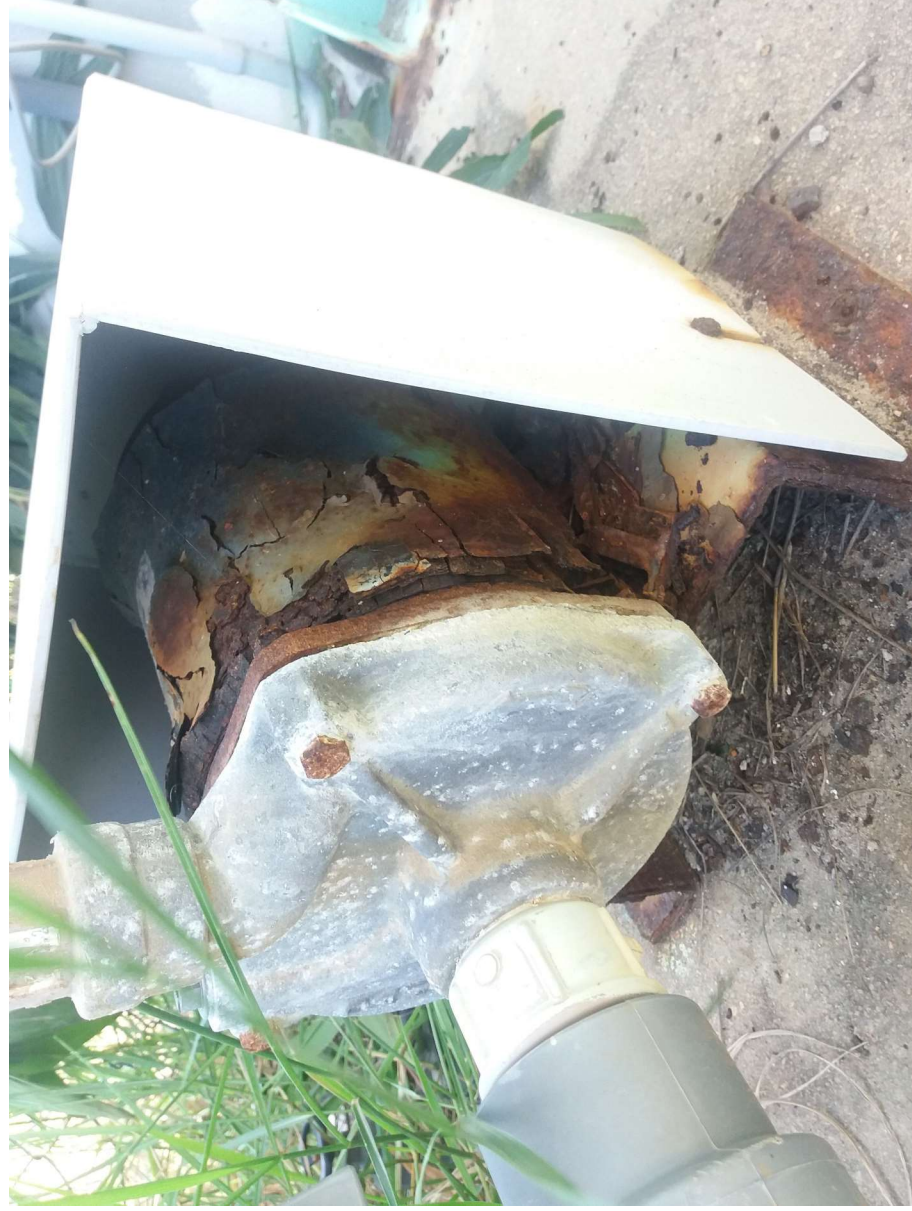
Foto 06: Substituição de bomba da retrolavagem e suporte
