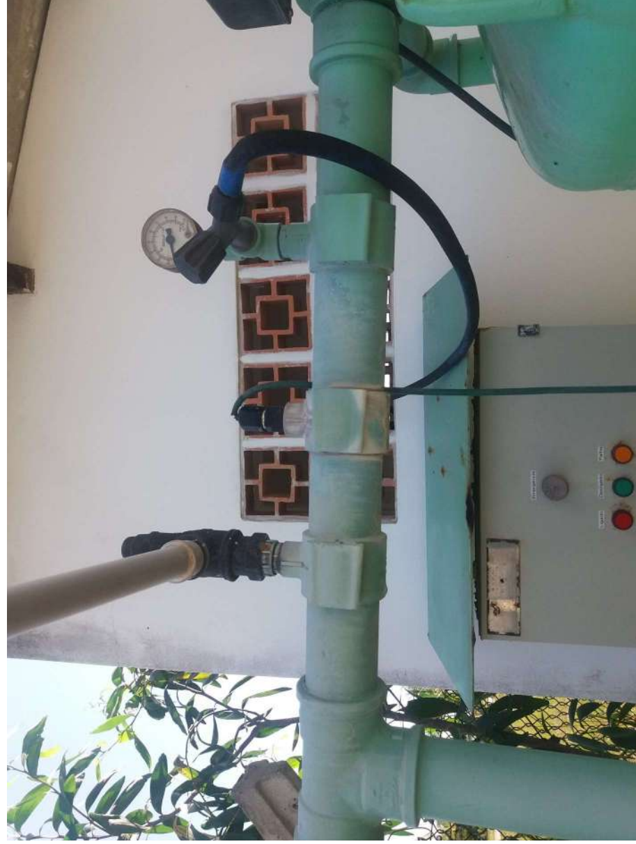
Foto 07: Substituição das mangueiras
