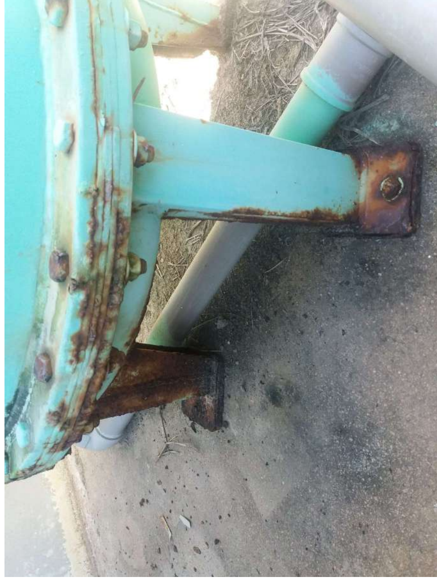
Foto 03: Tratamento contra corrosão
