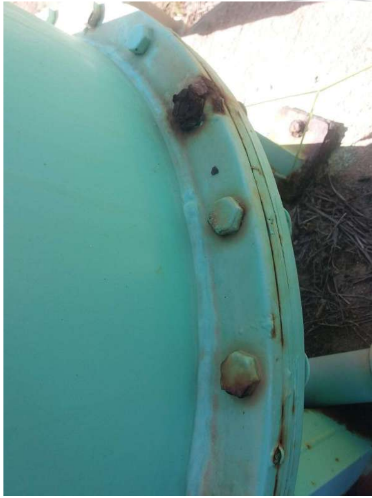
Foto 04: Tratamento contra corrosão
