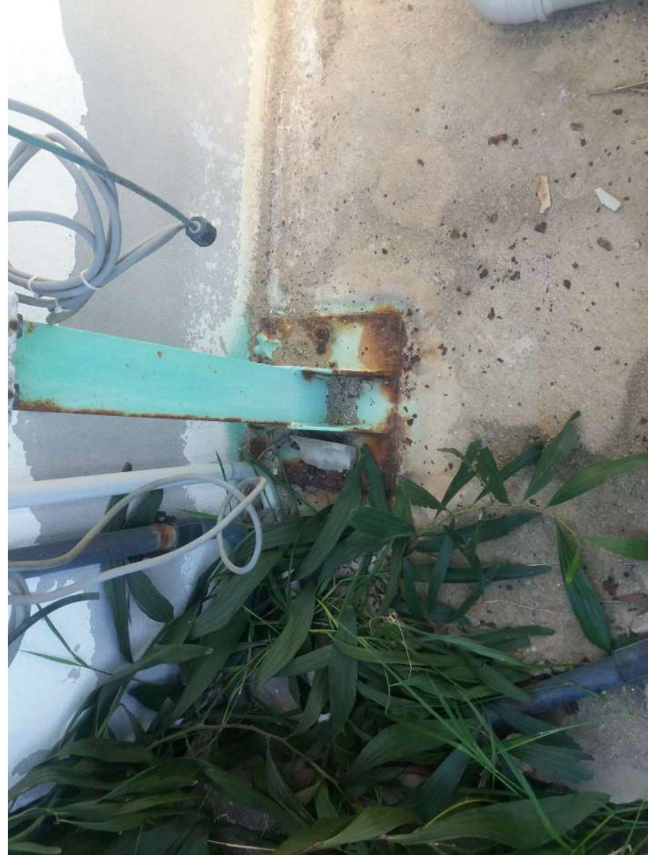
Foto 05: Tratamento contra corrosão
