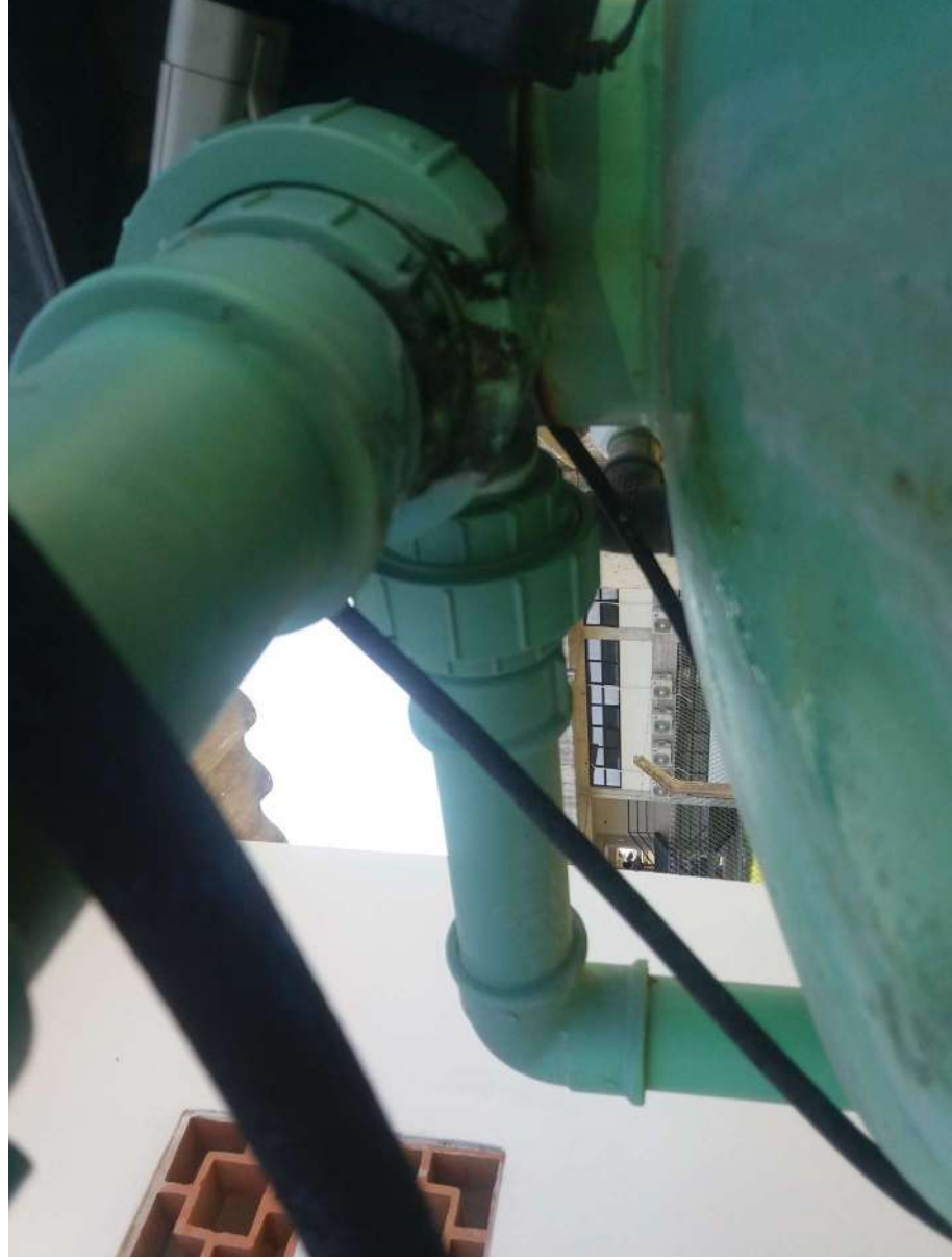
Foto 09: Verificação da estanqueidade e substituição das conexões hidráulicas defeituosas
