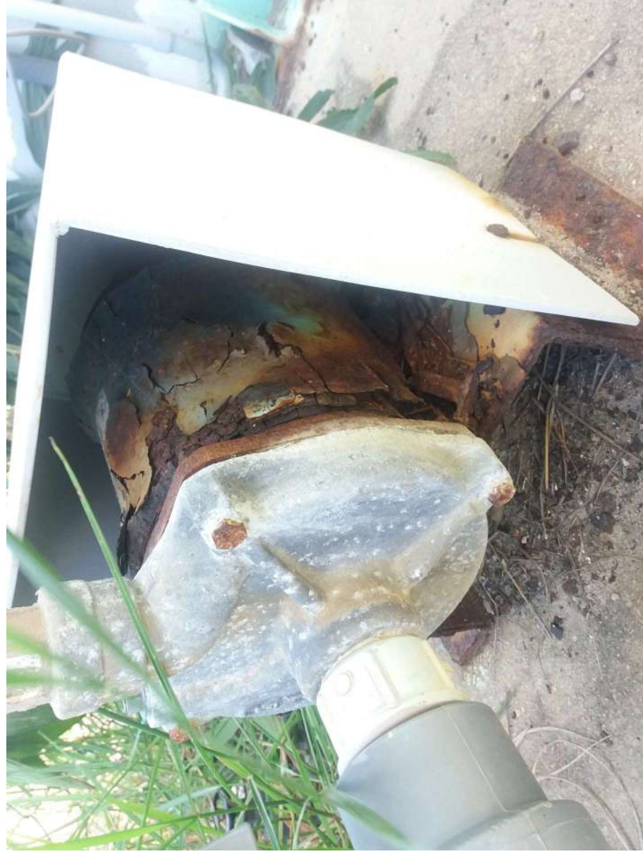
Foto 06: Substituição de bomba da retrolavagem e suporte
