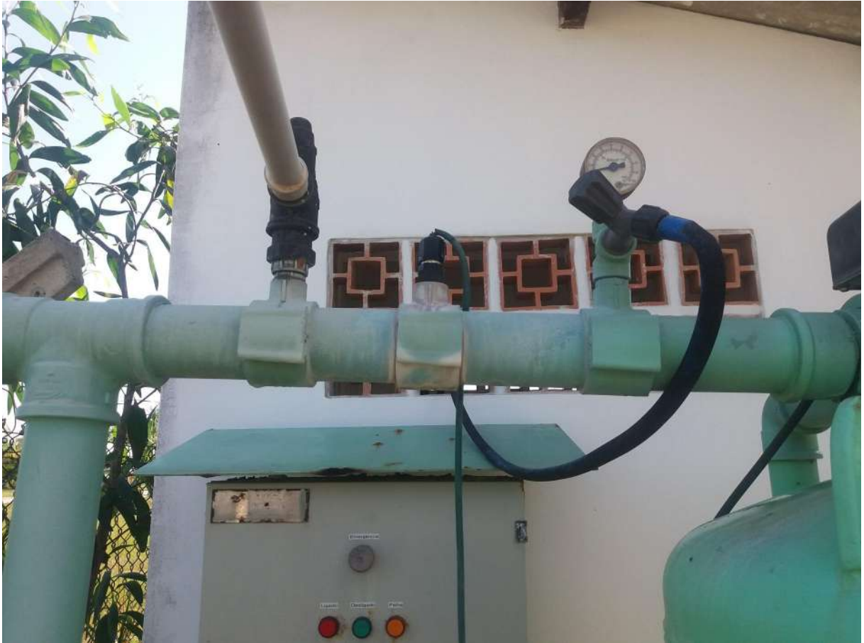
Foto 07: Substituição das mangueiras
