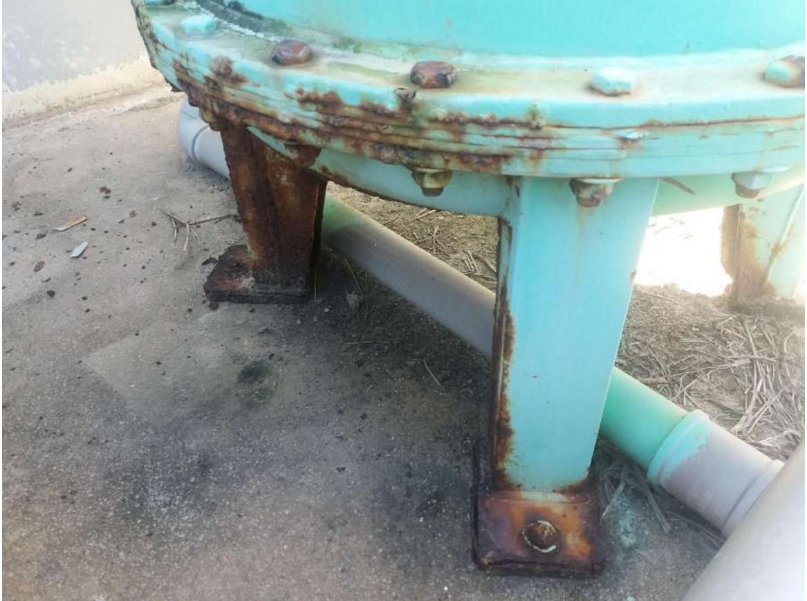
Foto 03: Tratamento contra corrosão
