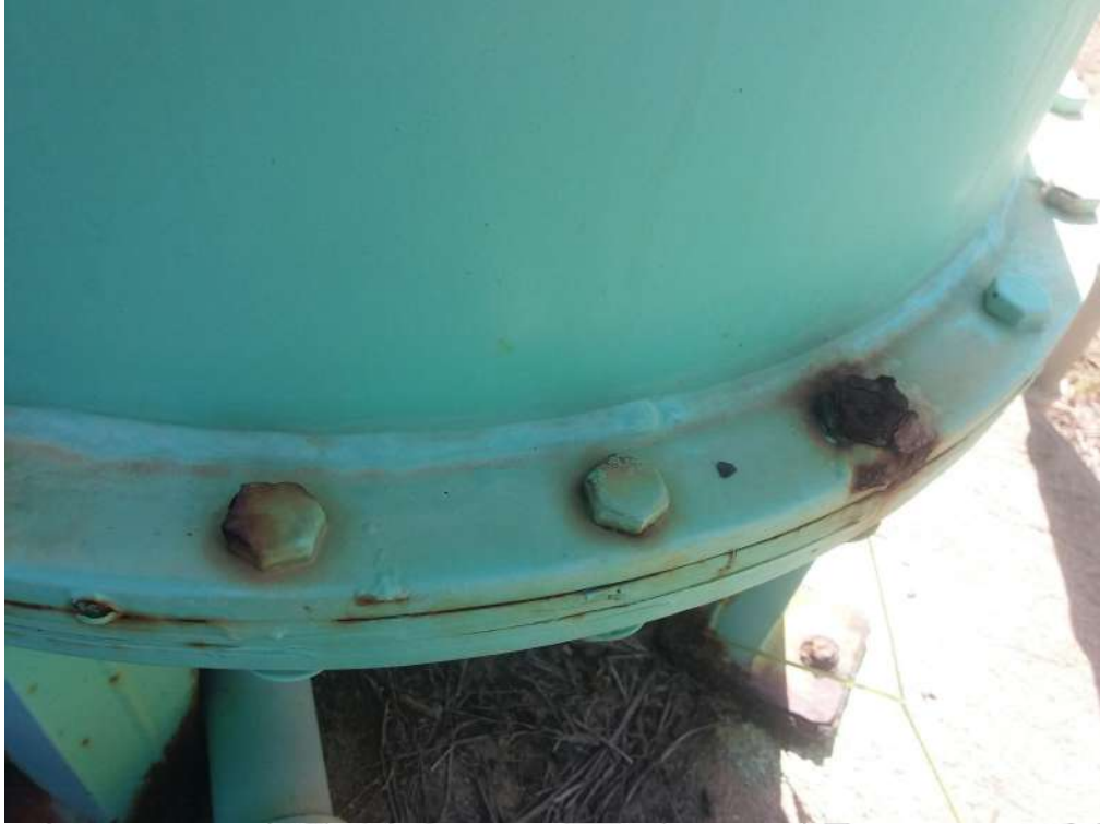
Foto 04: Tratamento contra corrosão
