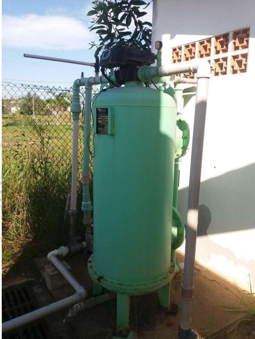
Foto 02: Verificação/substituição do elemento filtrante
