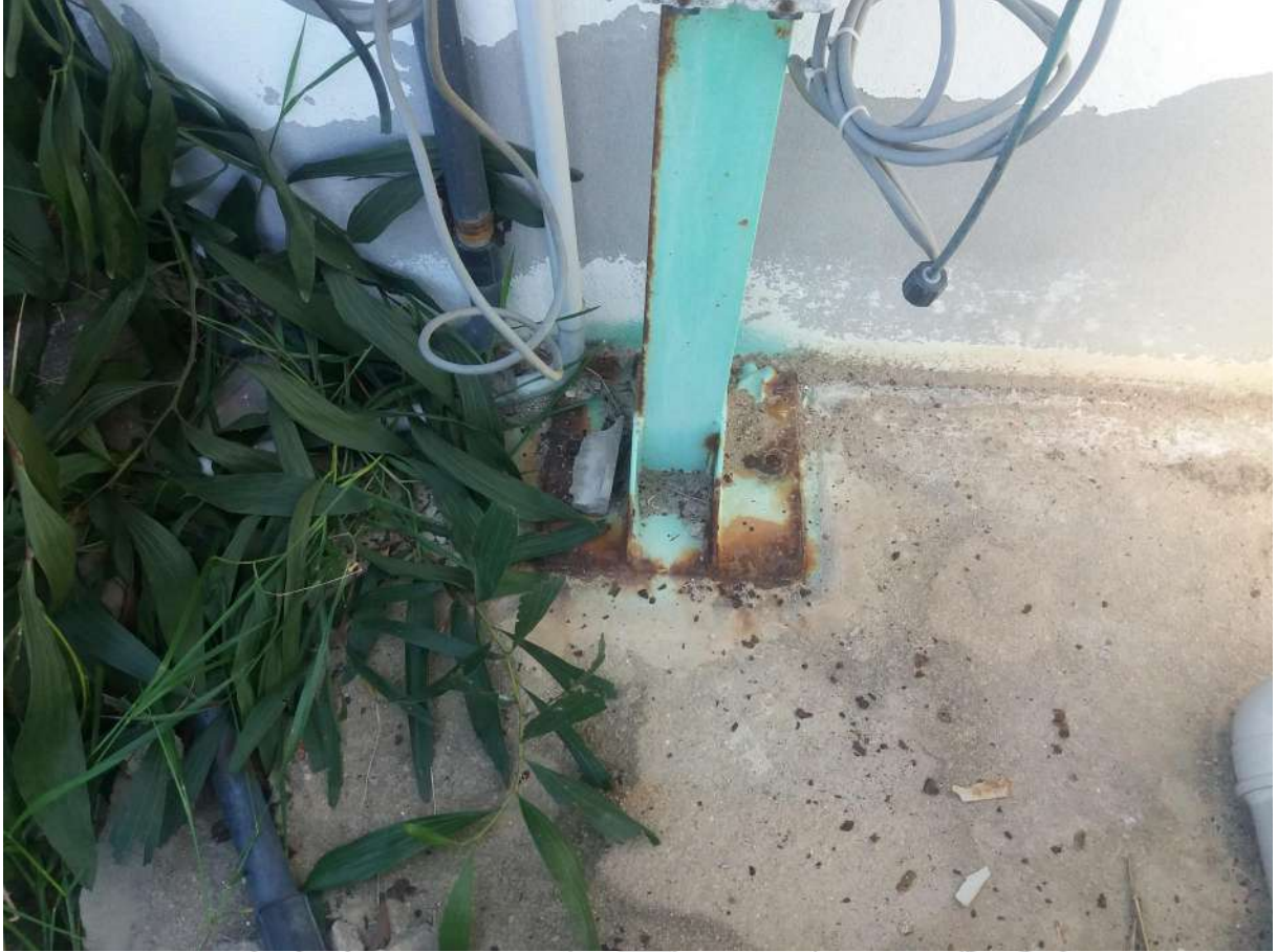
Foto 05: Tratamento contra corrosão
