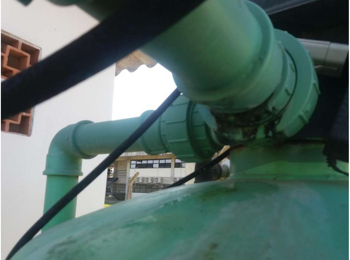
Foto 09: Verificação da estanqueidade e substituição das conexões hidráulicas defeituosas
