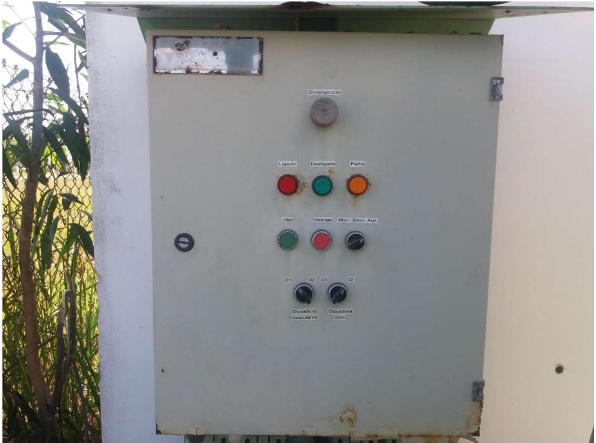
Foto 10: Substituição da caixa do quadro elétrico e avaliar os circuitos
