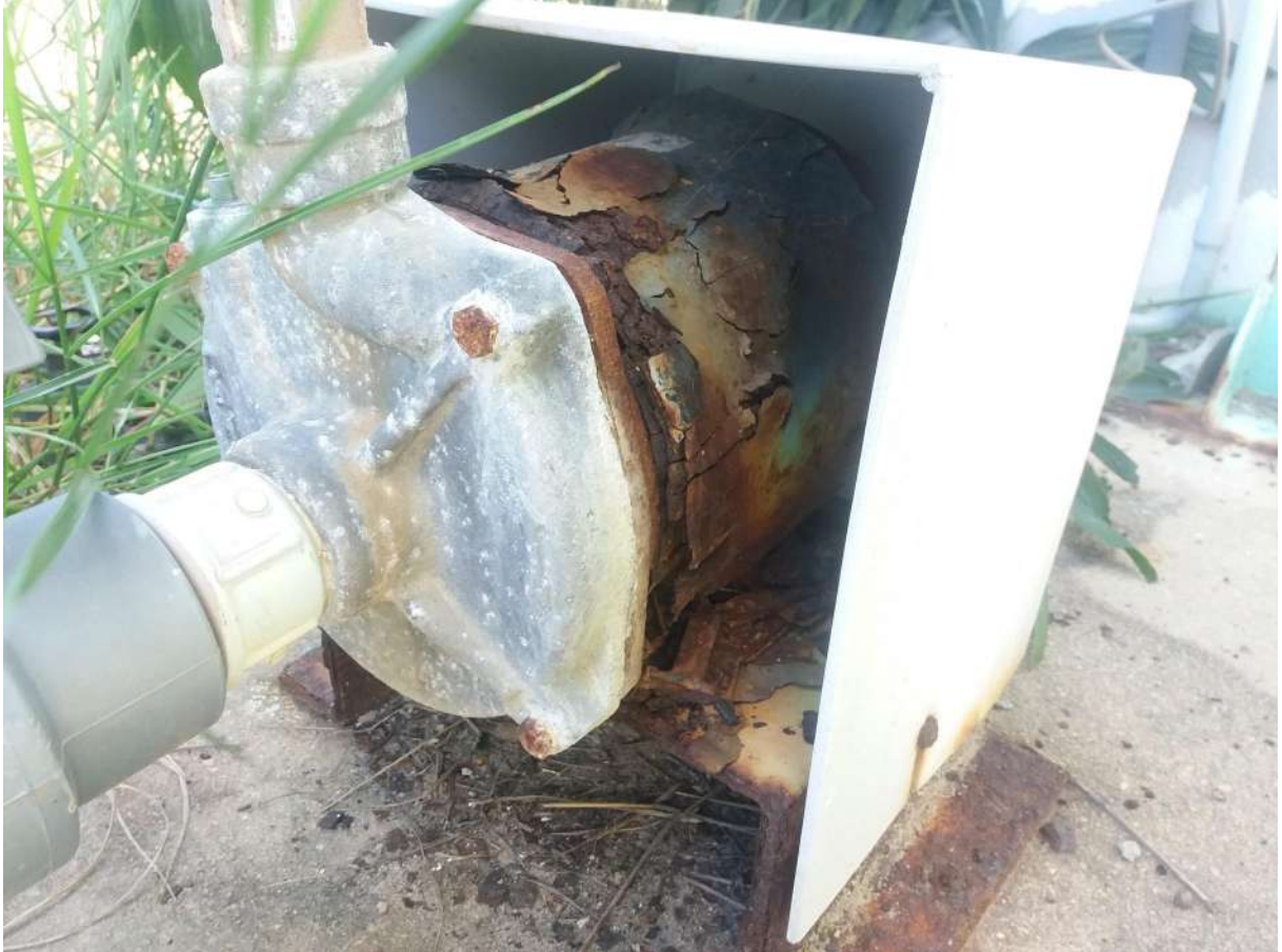
Foto 06: Substituição de bomba da retrolavagem e suporte
