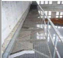
PLATAFORMA PARA MANUTENÇÃO DE AR-CONDICIONADO
